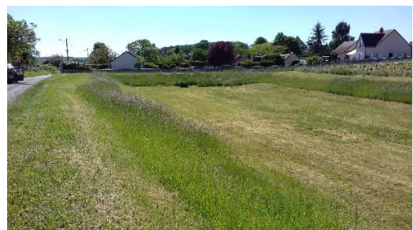
2. Bassin de rétention-infiltration à Vernou (37)
